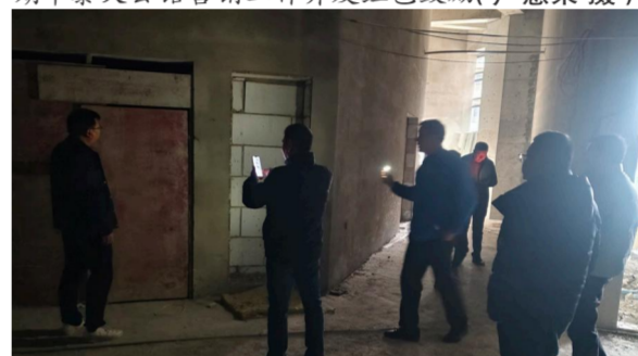
2月26日, 红安县人民医院新院区项目部进行春节后开工前综合检查(吴亚娟摄)
