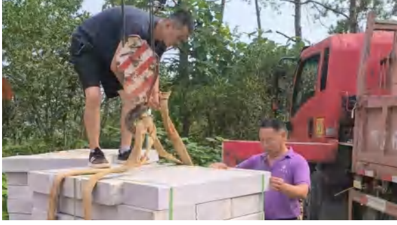
景区道路改造工程物料验收（姜欢 摄）
