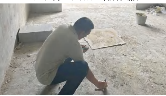
9月11日，工程部对九龙湾A区H9#楼H10#楼进行分户面积实测（胡万乐 摄）
