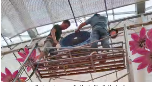
8月27日，四季花海景区花立方室内照明、风机改造安装（程世军 摄）
