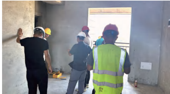
武穴金港汽车公园项目给排水管道打压试验（唐利 摄）
