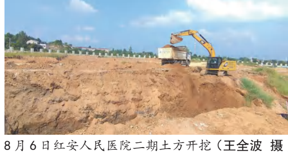
8月6日红安人民医院二期土方开挖（王全波 摄）
