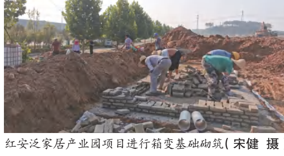
红安泛家居产业园项目进行箱变基础砌筑（宋健 摄）
